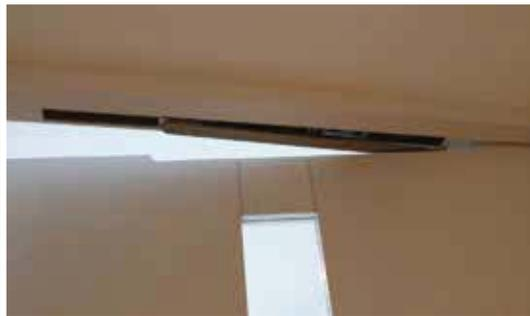
3バルブ方式なので、閉扉時の速度と、閉める扉まぎわの速度を変更でき、さらに快適に。
